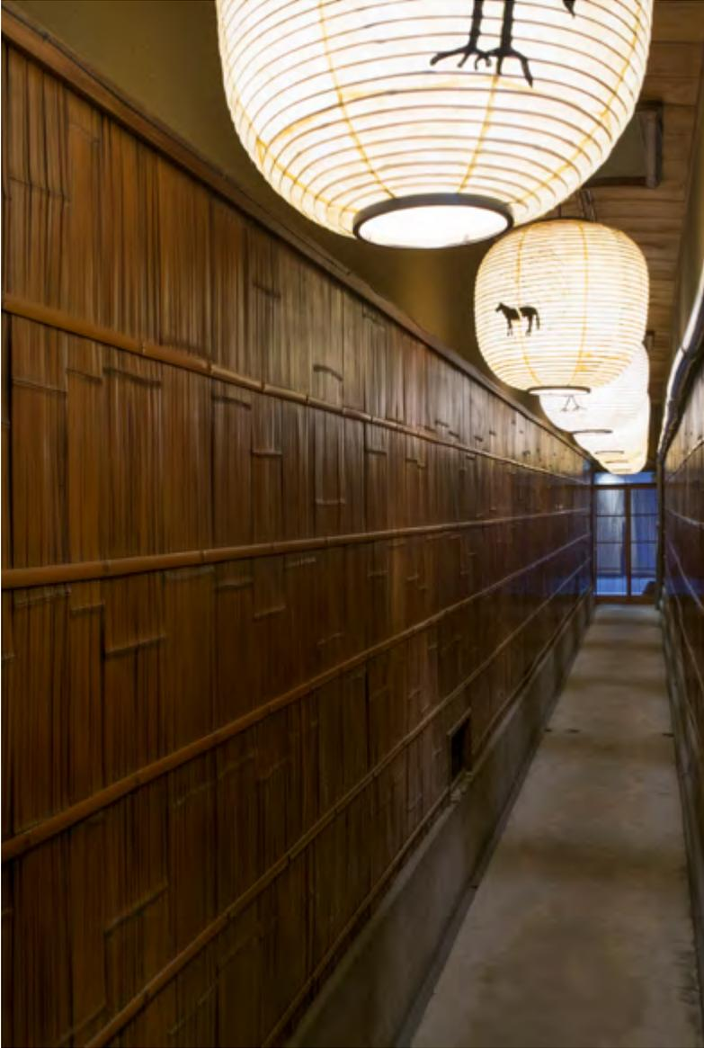
丸竹に背割を入れた後、専用の道具を用いて繊維に沿って叩くことで、板状にしたもの。主に京町屋の壁面装飾として用いられることが多く、不規則に入った割れ目が独特の雰囲気を出します。
